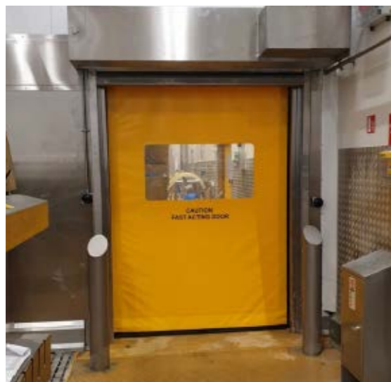
Bis zu 2,0 m/s mit der Standard-Frequenzregelung
