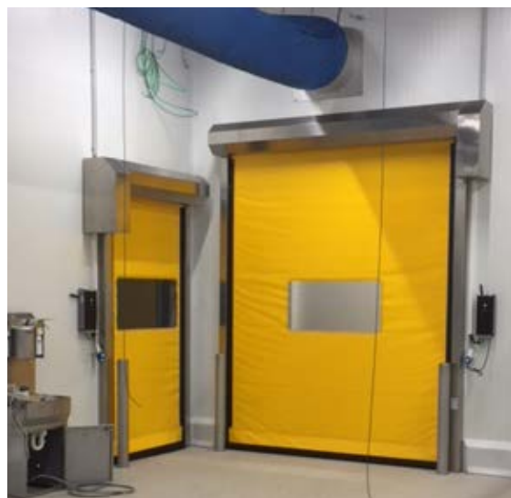
Pratique et nécessitant peu d'entretien: capot en acier inoxydable
