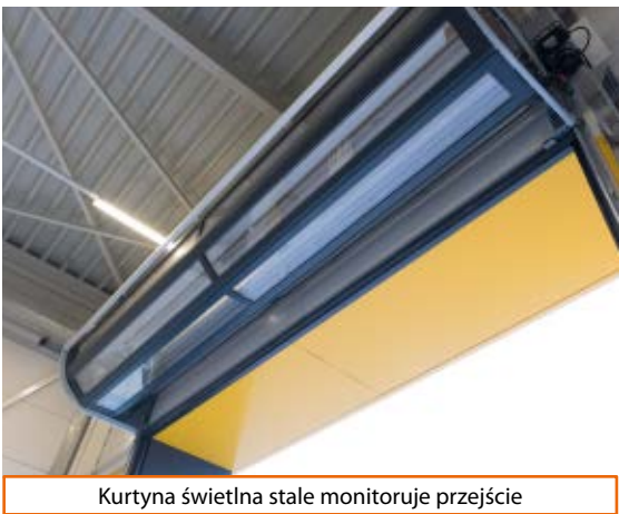
Kurtyna świetlna stale monitoruje przejście
