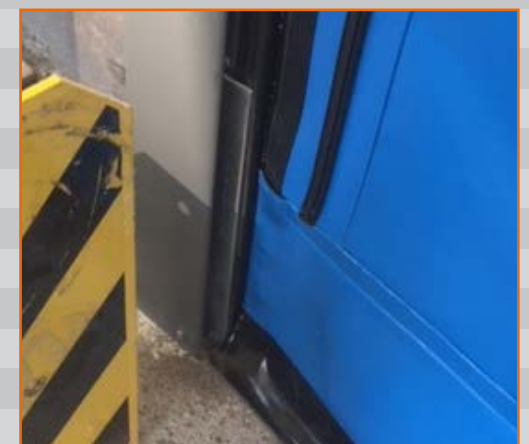
Führungsschiene mit Zip-System und Flex-Edge-Schließkante
