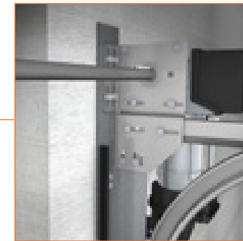
Kunststoffprofil mit Schaumstoff hinter der Eckzarge
